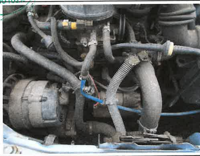
Fot.24. Komora silnika
